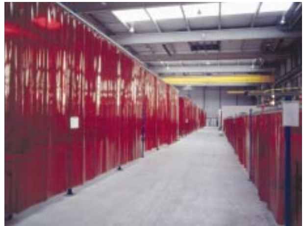
Abb.: 6 Lamellenvorhänge an Hakengleitern und C-Profil montiert.
